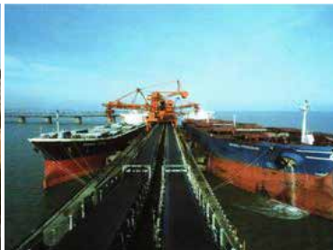
日照港(石臼所港)建設事業
