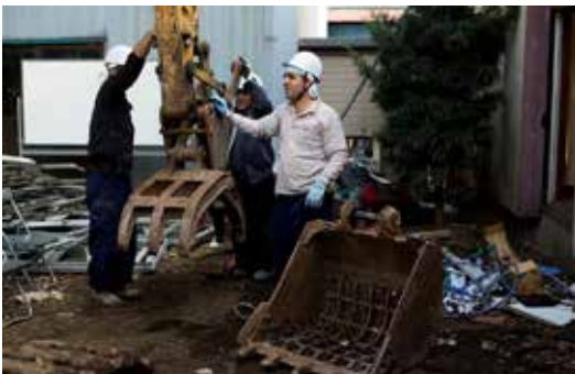
建設現場で働く外国人
